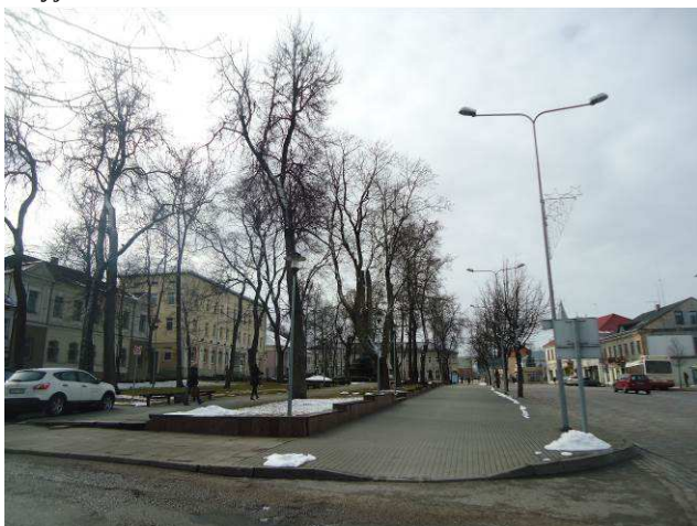
4 pav. Atraminės sienutės Kęstučio aikštės rytinėje dalyje
