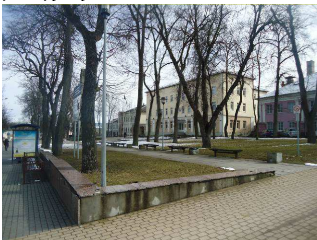
2 pav. Atraminės sienutės Kęstučio aikštės vakarinėje dalyje
