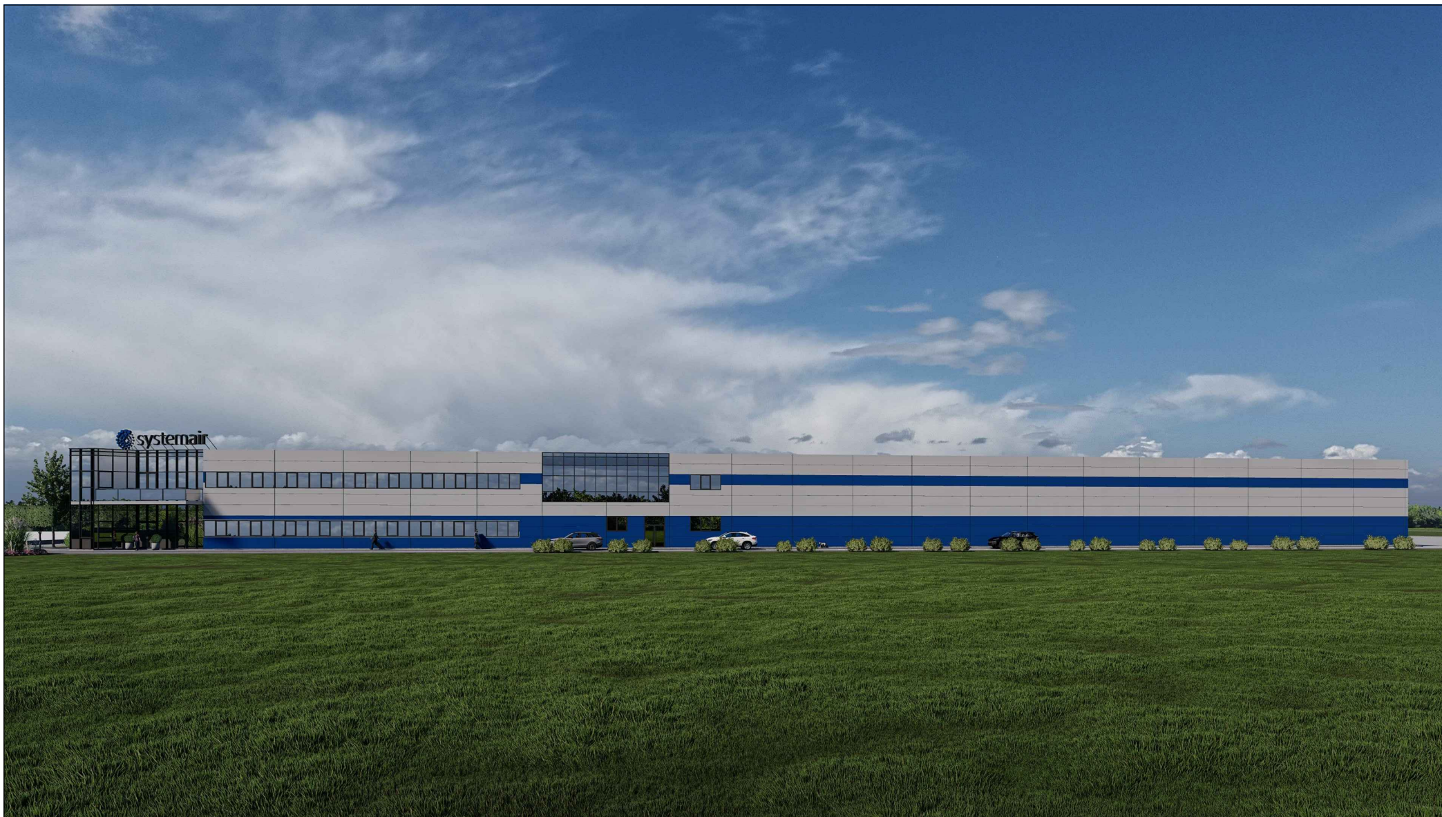
3 paveikslas. Pietrytinės pusės vaizdas - pagrindinis fasadas.
