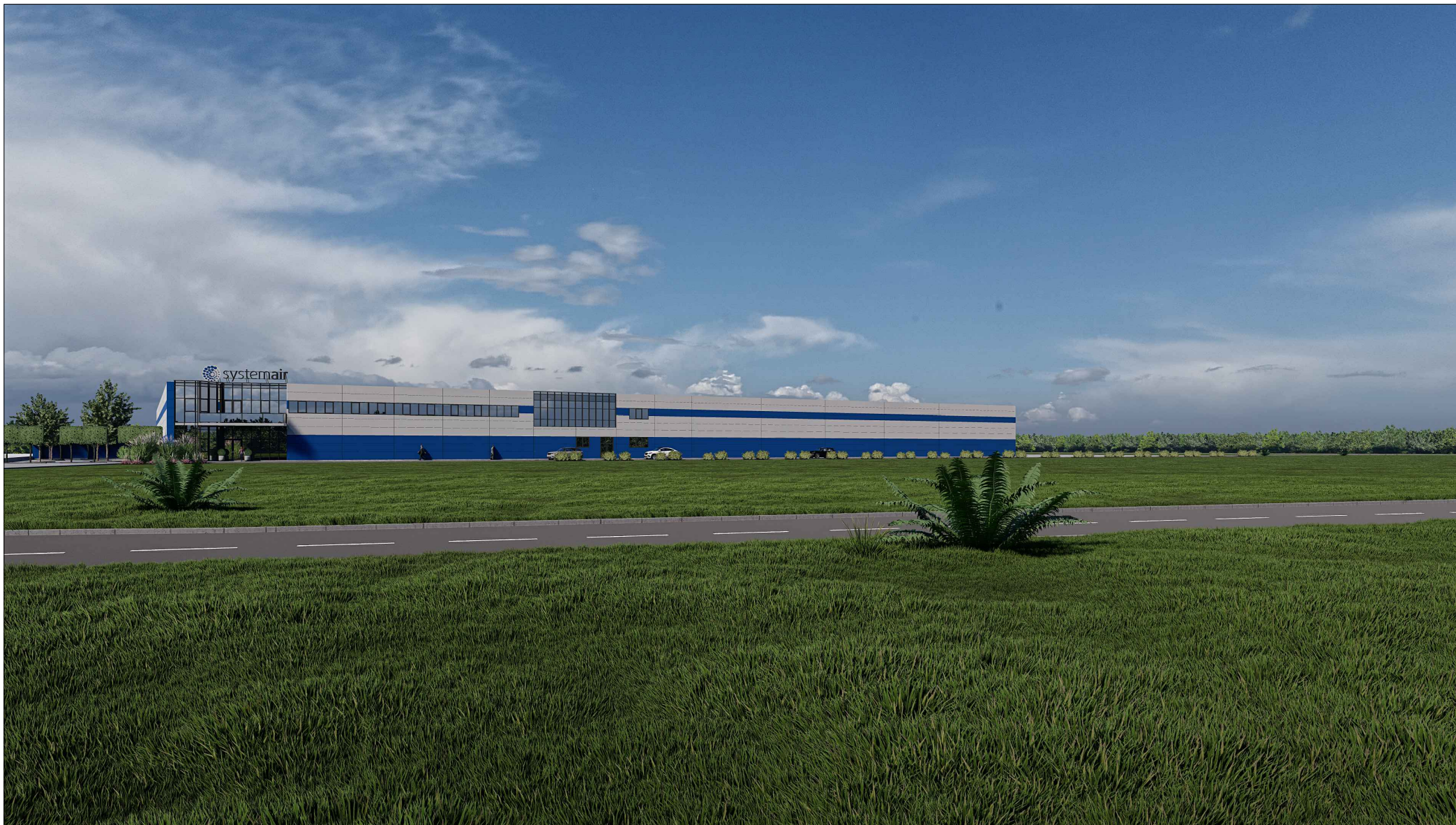
2 paveikslas. Pietrytinės pusės vaizdas - pagrindinis fasadas.
