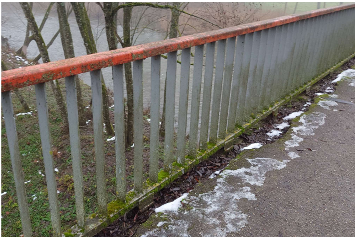
11 pav. Apsamanojė turėklai. Suires paklotas.
