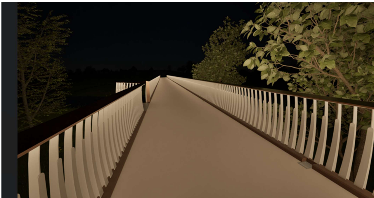
14 pav. Vientisas LED apšvietimas porankiuose
