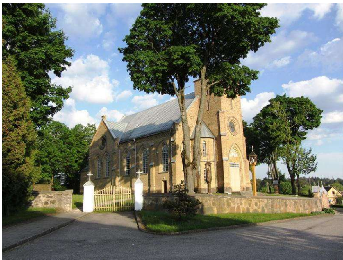
32 pav. Veprių Rožinio Švč. Mergelės Marijos bažnyčios foto ( https://kvr.kpd.lt ).
