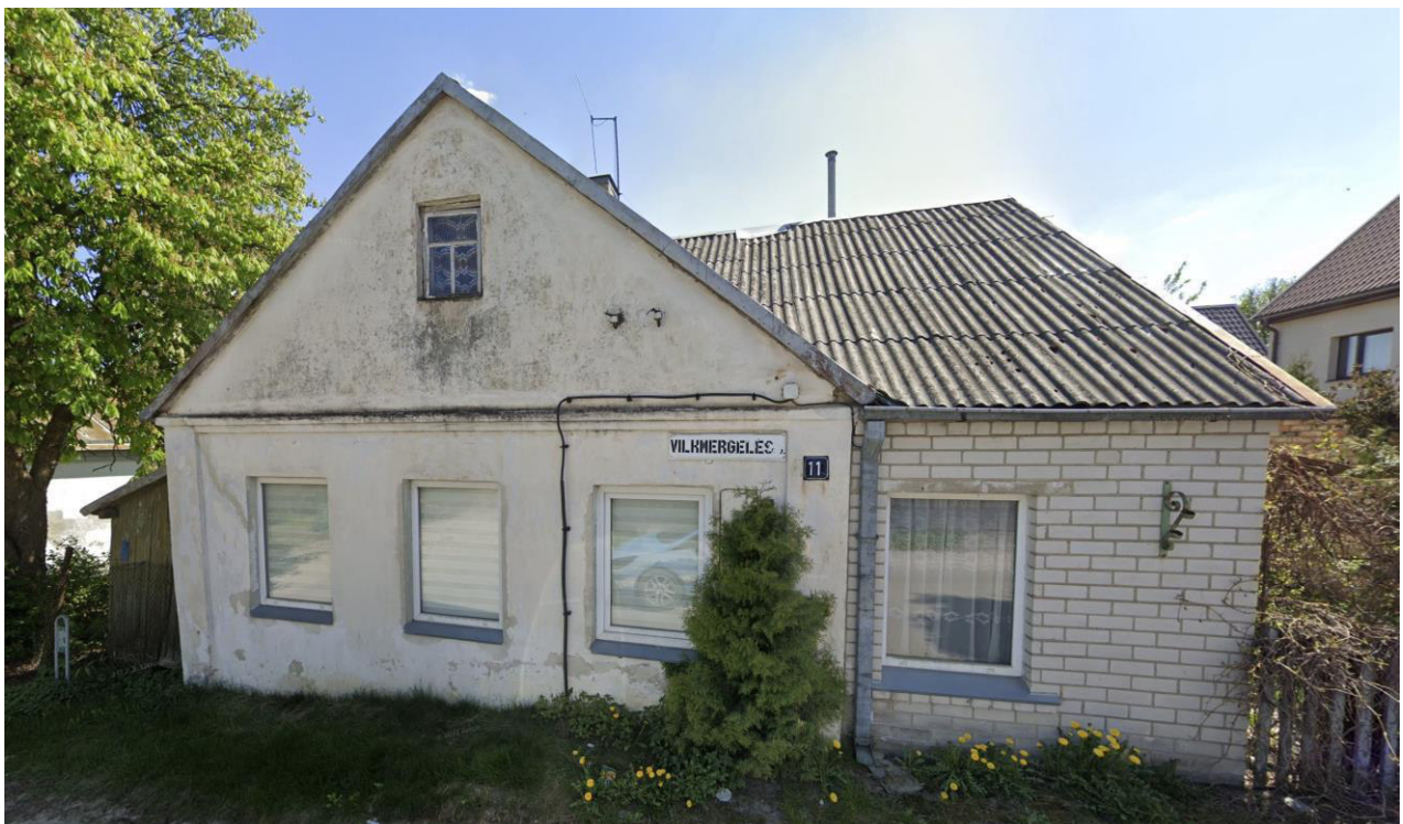
4 pav. Esamos situacijos fotofiksacija
