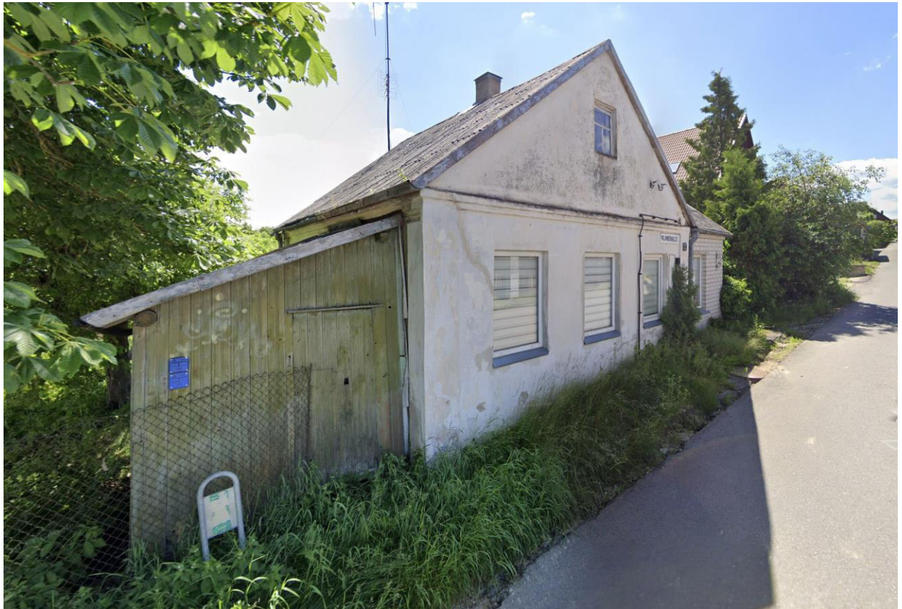
3 pav. Esamos situacijos fotofiksacija
