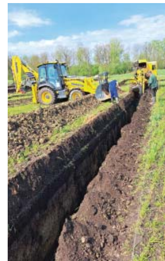
Drenažo remonto darbai Šaukavos k.
