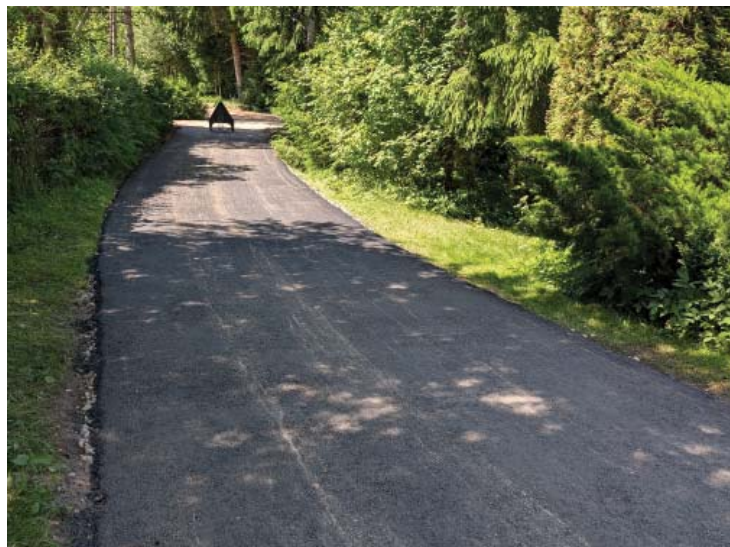
Vėjų g. asfaltas
