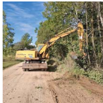
Kelių kelkraščių ir griovių atstatymo darbai
