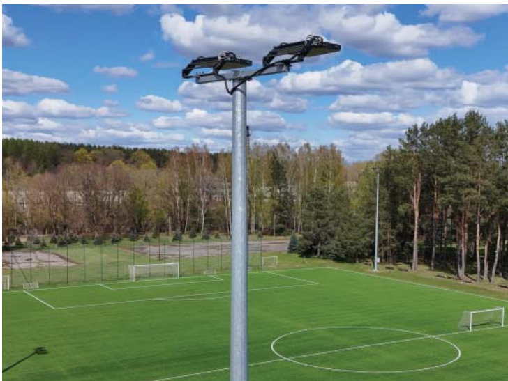
Įrengtas stadiono aikštės apšvietimas
