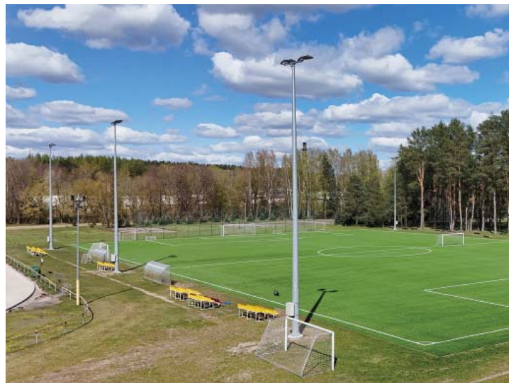
Įrengtas stadiono aikštės apšvietimas
