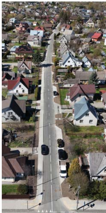
Birutės g. PO rekonstrukcijos
