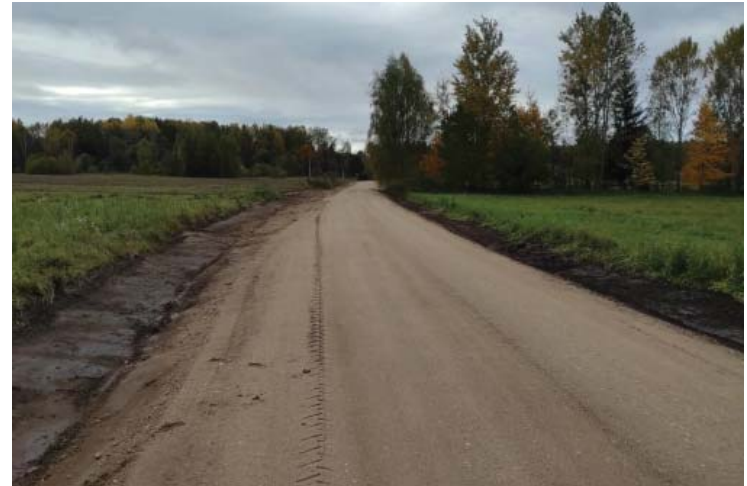
Griovių atstatymas Knyzlaukio k.
