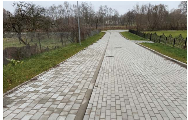
Pakalnės g. rekonstrukcija
