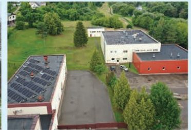
Saulės elektrinė ant pastato stogo Gėlių g. 18
