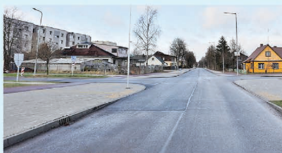
Antakalnio g. rekonstrukcija
