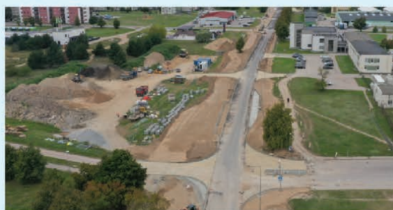
Antakalnio g. rekonstrukcija
