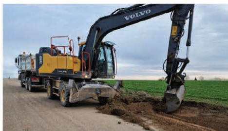
Kelio remonto darbai Pivonijos sen.
