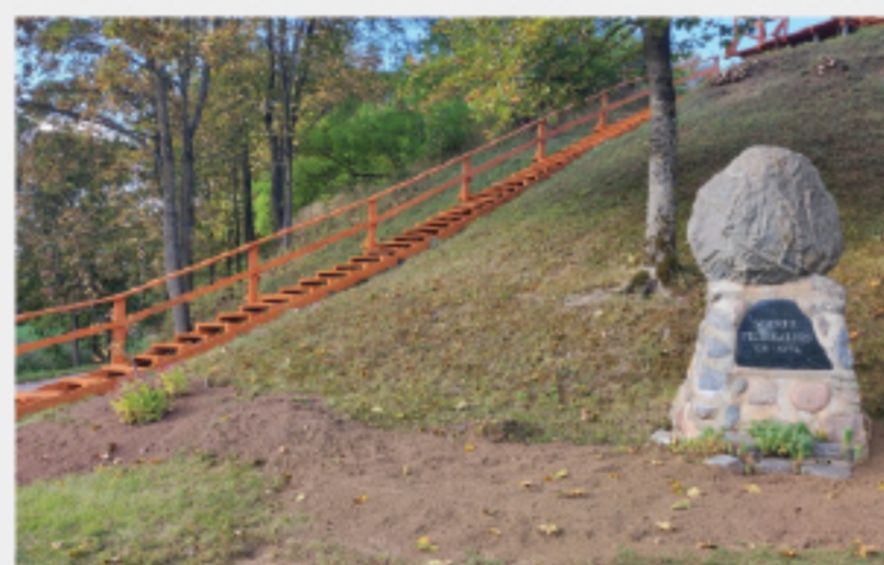
Atnaujinti laiptai į Veprių piliakalnį
