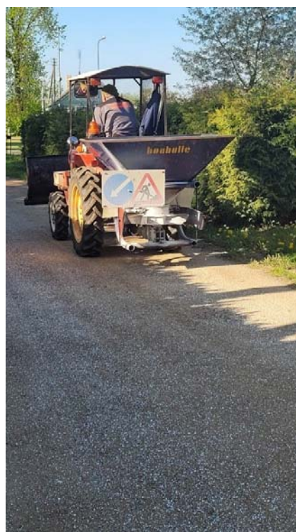
14 pav. Žvyrkelių barstymas kalcio chlorido druska
