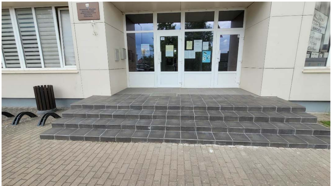
5 pav. Suremontuoti administracinio pastato laiptai
