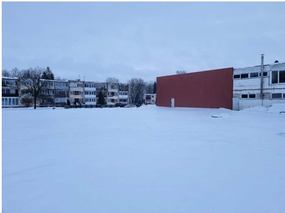
7 pav. Pastato fasadas po remonto
