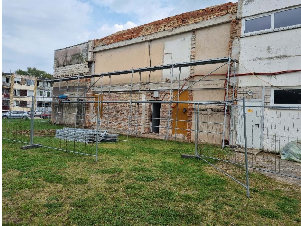
6 pav. Pastato fasadas prieš remontą
