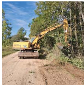
Kelių kelkraščių ir griovių atstatymo darbai
