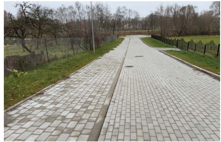
Pakalnės g. rekonstrukcija
