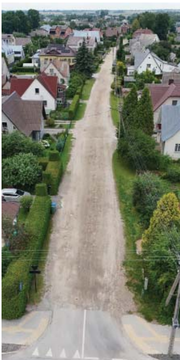
Birutės g. PRIEŠ rekonstrukciją
