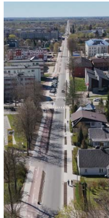
Deltuvos g. PO rekonstrukcijos
