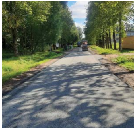
Statikų gatvės asfaltavimas
