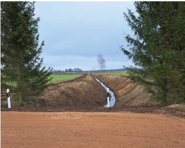
Rekonstruotas melioracijos griovys Bimūnų k.
