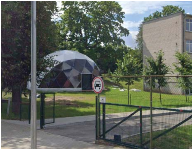
Lauko klasių – kupolų Sodų g. 7 ir Vaižganto g. 44 įrengimo darbai
