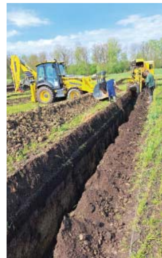
Drenažo remonto darbai Šaukavos k.
