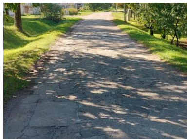
Asfaltbetonio duobių taisymas
