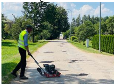
Asfaltbetonio duobių taisymas
