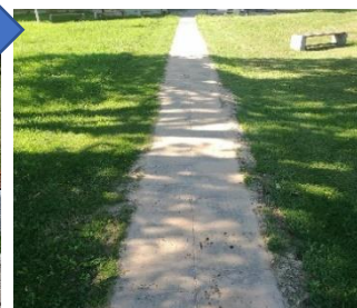
Šaligatvio Liaušių k. atnaujinimas
