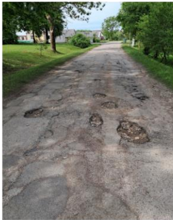
Asfaltbetonio duobių taisymas, žvyravimas išdaužų vietose
