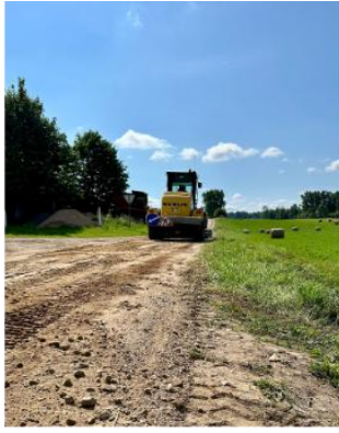
Kelių greideriavimo darbai ir kelių barstymas dulkėtumą mažinančiomis medžiagomis
