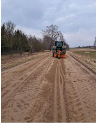
Kelių greideriavimo darbai ir kelių barstymas dulkėtumą mažinančiomis medžiagomis
