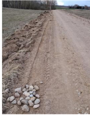
Kelių greideriavimo darbai ir kelių barstymas dulkėtumą mažinančiomis medžiagomis
