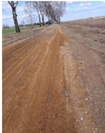
Asfaltbetonio duobių taisymas, žvyravimas išdaužų vietose
