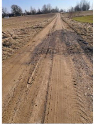
Kelių greideriavimo darbai ir kelių barstymas dulkėtumą mažinančiomis medžiagomis
